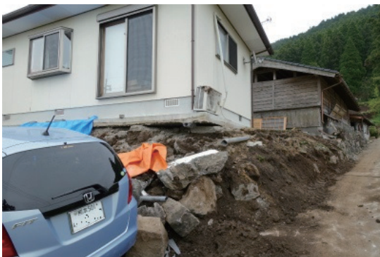
写真10 崩壊した擁壁
