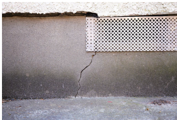
換気口付近の ひび割れ
