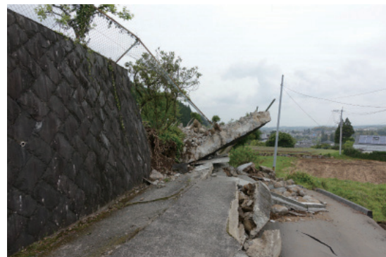
写真11 崩壊した擁壁
